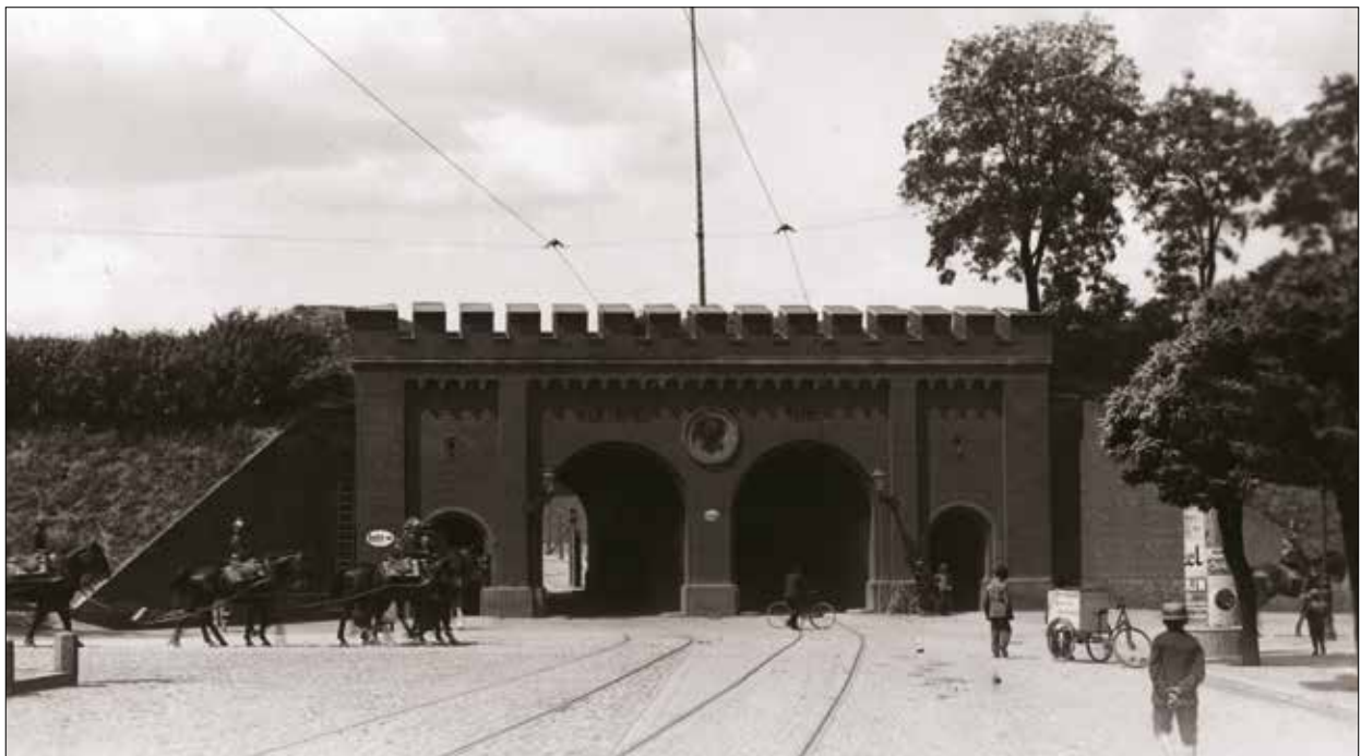
1. Brama Berlińska [Berliner Thor] z wałami twierdzy od strony wewnętrznej na osi ul. Święty Marcin i skrzyżowaniu z ul. Wałową [obecnie ul. Kościuszki], z prawej fragment budynku intendencji wojskowej, ok. 1889 r., fot. ze zb. Biura Miejskiego Konserwatora Zabytków w Poznaniu [dalej: ze zb. MKZ]/cyryl.poznan.pl [2x]
