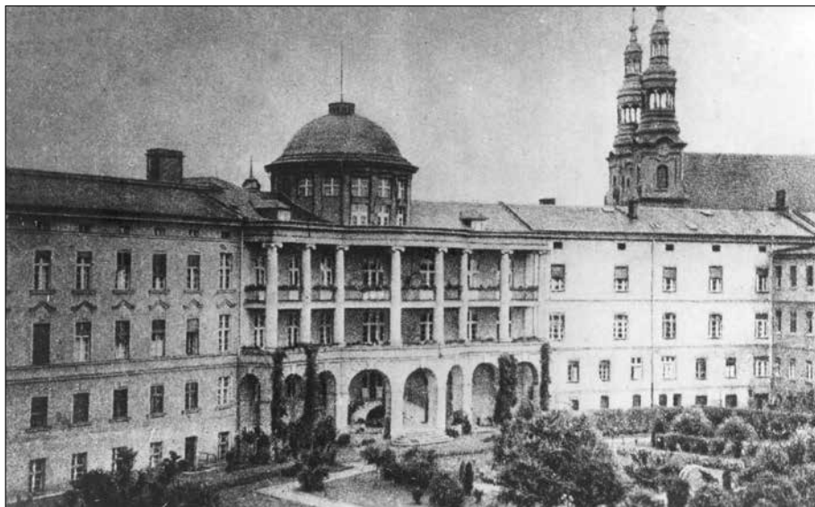
10. Widok na południową elewację Szpitala Przemienienia Pańskiego, lata 20.–30. XX w., fot. ze zb. MKZ
